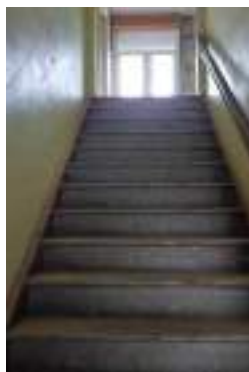
l'escalier d'accès aux logements
